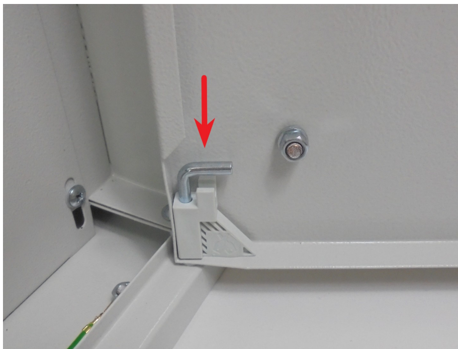
Rys. 8. Mocowanie zawiasu
